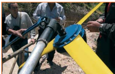
Muntatge d'un Aerogenerador
